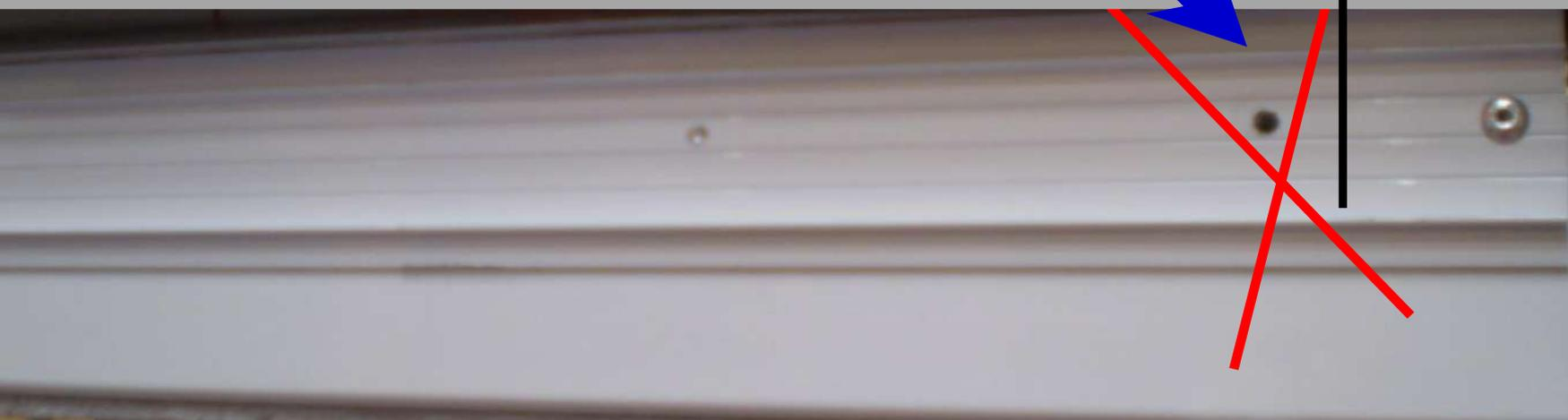
**AO FAZER O FURO DE FIXAÇÃO DO TRILHO SUPERIOR E GUIA/TRILHO INFERIOR, FAÇA COM CUIDADO. QUANDO DO AFASTAMENTO DAS ROLDANAS DO VIDRO PIVÔ SUPERIOR E INFERIOR ( TEMOS ± 30 mm ) ESPAÇO PARA REBITAR O TRILHO NO PERFIL “U” SEM DANIFICAR A BASE DAS ROLDANAS DO VIDRO PIVÔ.**
