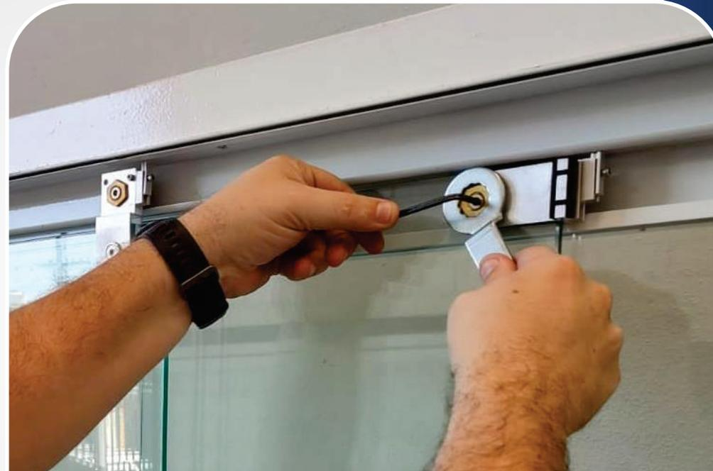
Regule as portas utilizando uma chave allen4 e uma chave de boca 19 ou uma chave de instalação nas roldanas excêntricas. Após a regulagem das roldanas, regule o limitador de segurança.
